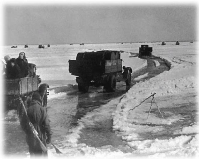
Павлом Павловичем Кобеко, изучила механические свойства ледового покрова (его прочность, хрупкость, грузоподъемность, условия пролома) и на основе этого разработала правила движения автоколонн по льду. Благодаря строгому выполнению этих правил, дорога действовала без аварий, не было случаев разрушения льда из-за деформации или нагрузки при движении транспорта.
